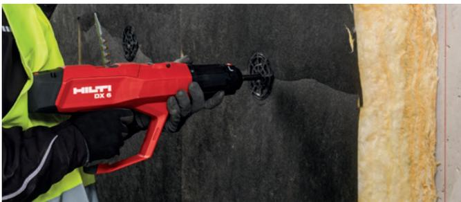
Wärmedämmung bis 200 mm kann in Beton einfach und effizient mittels Direktmontage befestigt werden. Die Kombination aus dem Bolzensetzgerät und den Dämmstoffbefestigern X-IE setzt Massstäbe in punkto Sicherheit und Geschwindigkeit. Natürlich bieten wir Ihnen auch die passende Dübel- oder Schraublösung zur Dämmstoffbefestigung für alle Untergründe an.
