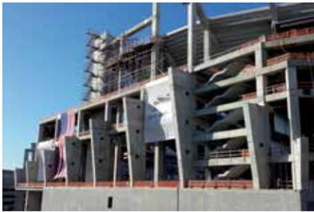
Construction adjacente simple d'éléments en béton.
