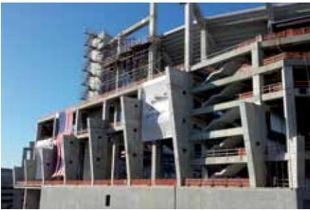
Einfache Anschlusskonstruktion von Betonelementen
