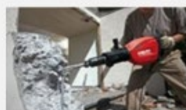
Wiercenie i rozbiórka
