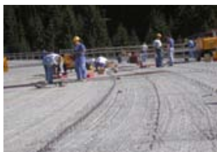
Rysunek 3: Modernizacja nawierzchni jezdni na moście
