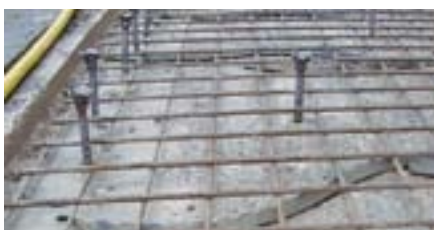
Zespoleńie betonu z betonem
