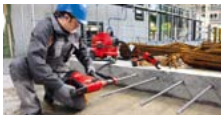
Połączenia zbrojenia uzupełniającego
