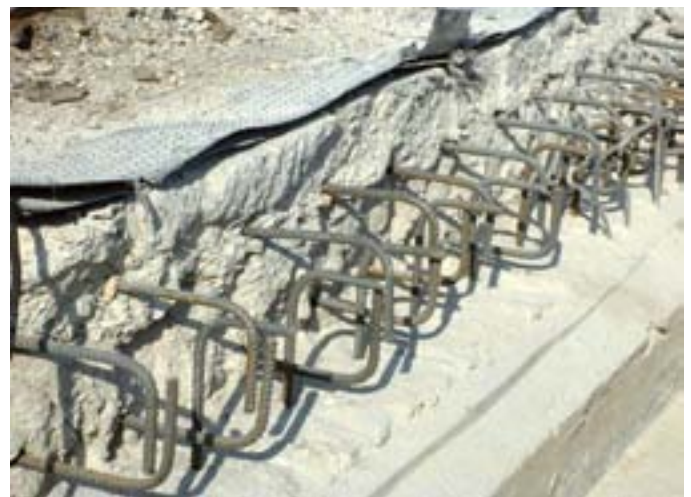
Naprawa przyczółka mostowego
