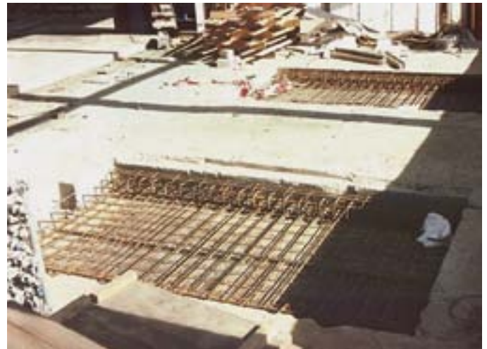
Uzupełnienie konstrukcji stropu
