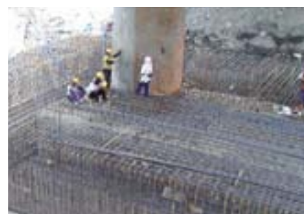
Rysunek 5: Wzmocnienie fundamentów
