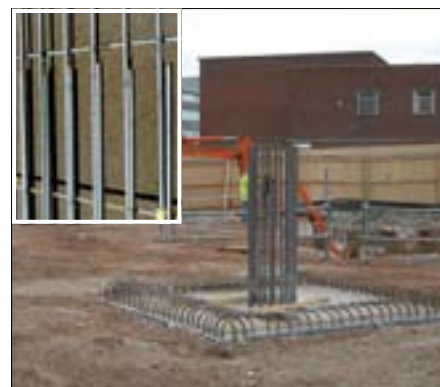
Połączenie prętów na zakład
