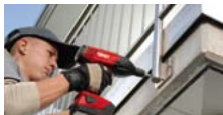
Montaż barier i balustrad
