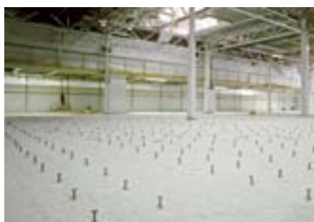
Rysunek 4: Wzmocnienie stropu w budownictwie przemysłowym
